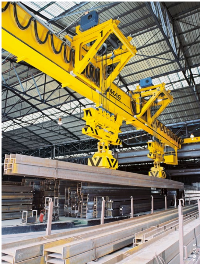
Synchronisation der Bewegungsabläufe zweier Hubwerke durch Master-Slave-Funktion
